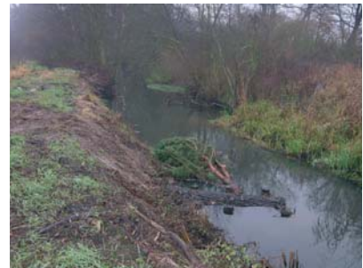
Abb. 27: Raubaum zur Sicherung der Gewässersohle
