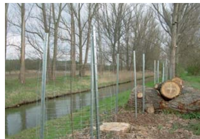
Abb. 37: Umbau standortuntypischer Gehölze an der Nuthe
