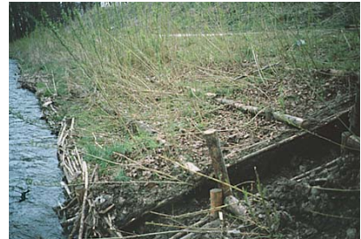
Abb. 31: Weidenspreitlage als Ufersicherung mit Fixierung durch Derbstangen und Rundholzpfähle sowie Fußsicherung durch Faschinen
