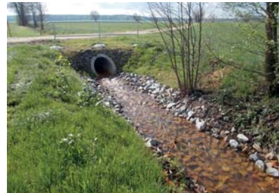
Abb. 24: Steinschüttung zur Sicherung der Gewässersohle
