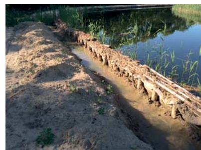
Abb. 29: Faschinen zur Ufersicherung
