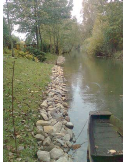
Abb. 28: Steinschüttung zur Ufersicherung
