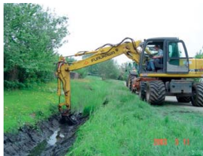
Abb. 16: Maschinelle Grundräumung mit Bagger
