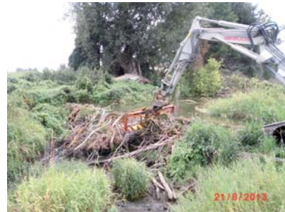
Abb. 41: Entfernen eines Biberdamms
