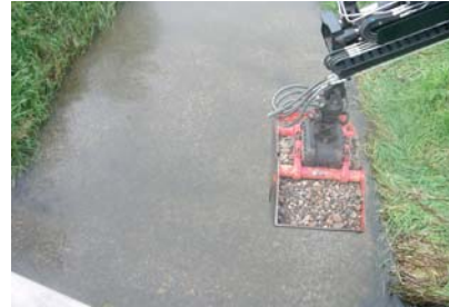
Abb. 34: Einbringen von Kiessubstrat in die Dosse unterhalb Wittstock
