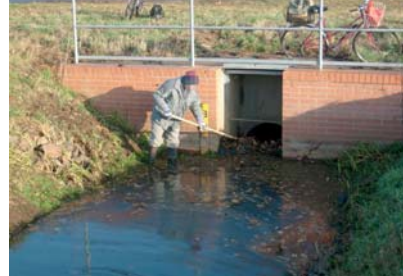
Abb. 20: Beräumung des Abflussprofils von Abflusshindernissen von Hand
