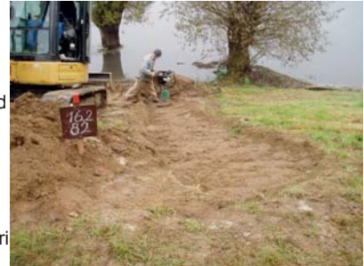
Abb. 43: Verschließen einer Biberröhre
