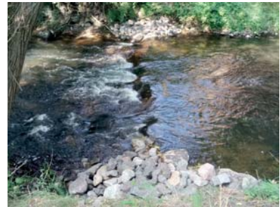
Abb. 26: Stütزشwelle aus Riegelsteinen mit drei Lücken in der Dosse bei Hohenofen
