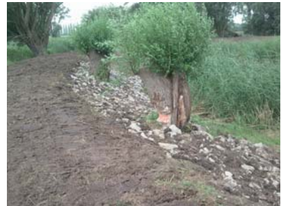
Abb. 48: Steinschüttung als Uferschutz vor wühlenden Tieren
